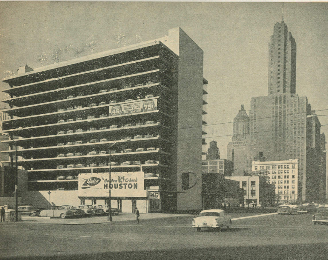
Un moderno parcheggio ad ascensori della Parking Authority di Chicago.
