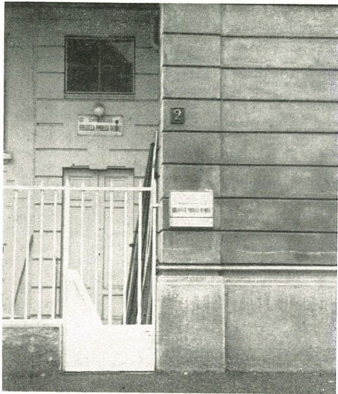
Punto di Prestito « MAC MAHON », Via Mottarone, 2. L'ingresso.
